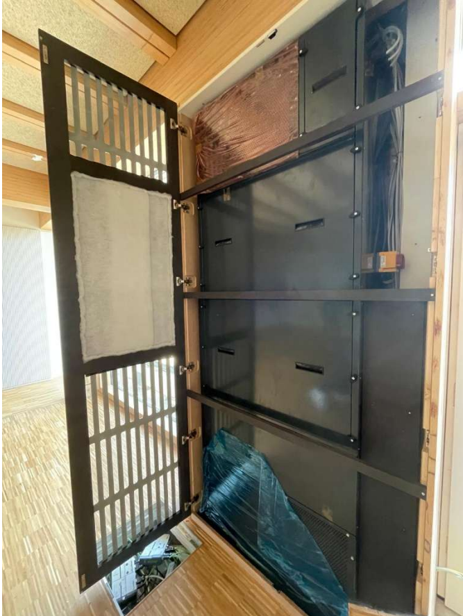
Abbildung 1, Fassadengerät zum Heizen, Kühlen und Lüften
