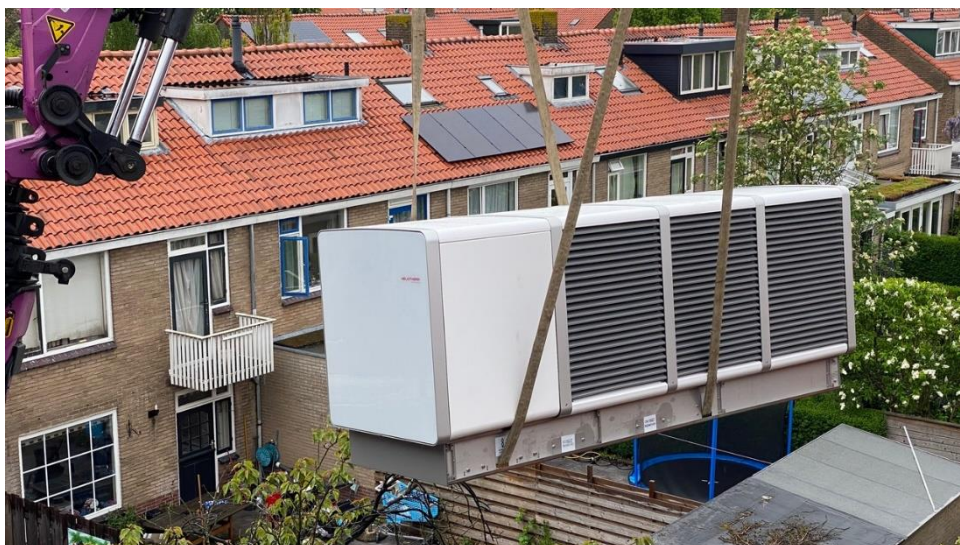
Abbildung 3: Montage einer Wärmepumpe
