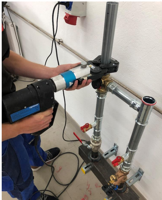
Abb.: 2 Zusammenbau Verteiler-Baugruppe
