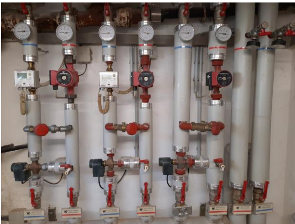
Abb. 3 Heizungsverteiler Schulgebäude
